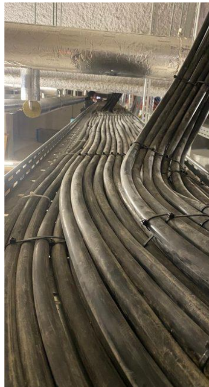
Kabelverlegung auf Trassen
