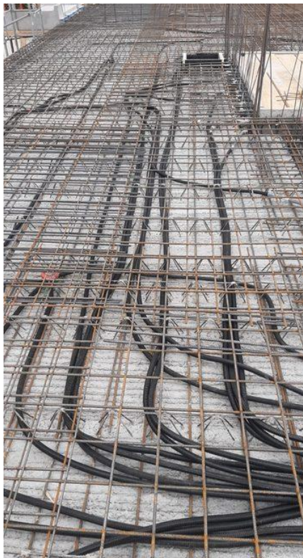
Leerrohrverlegung in der Decke
